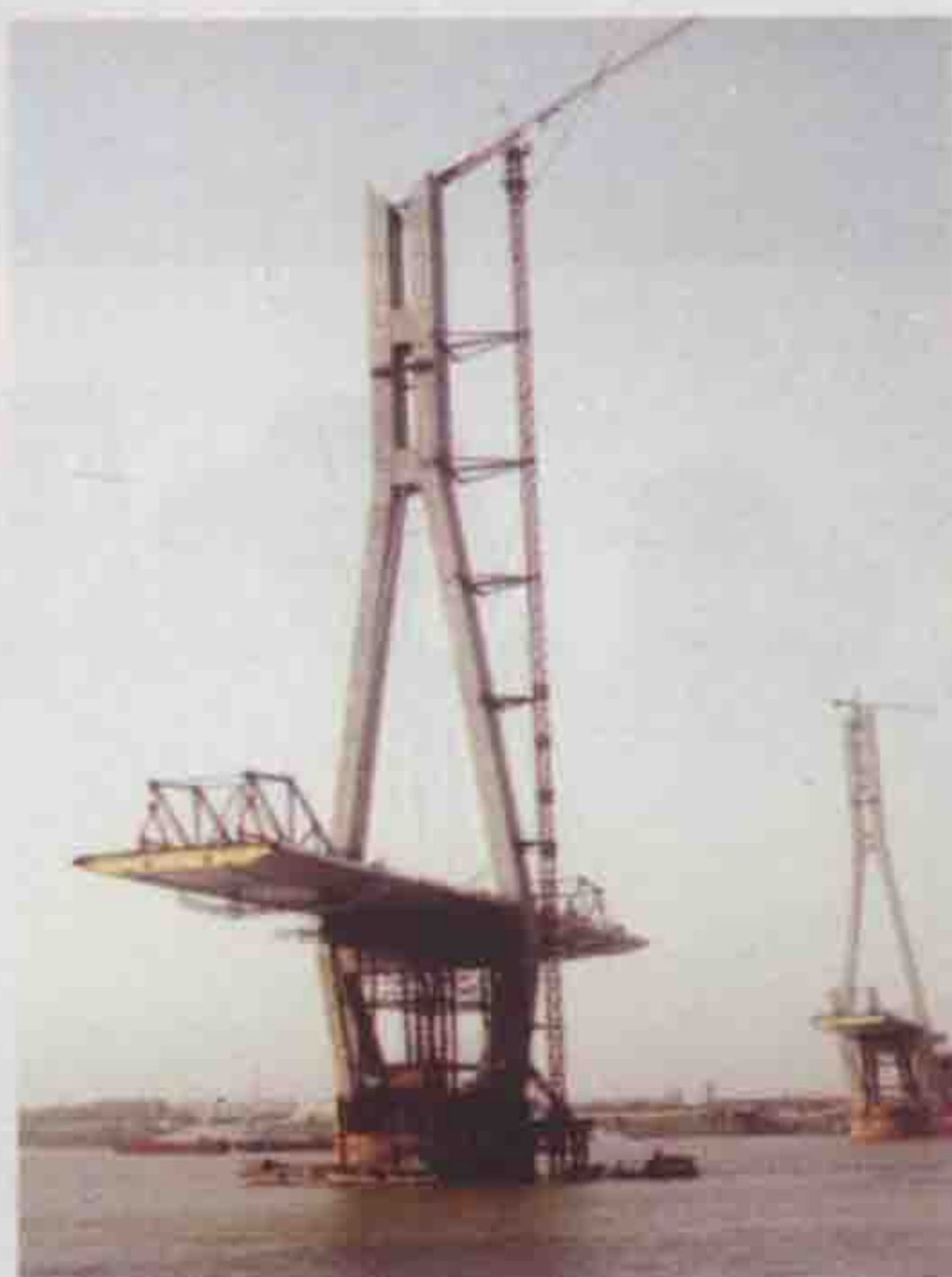
正在施工中的安庆长江大桥，主搭及南引桥由中港二航局承建。
