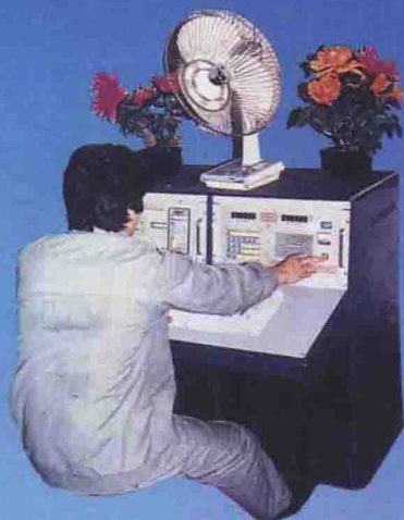
△微机控制沸腾炉
