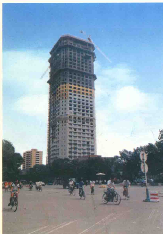
图 18—2 正在施工的天津国际大厦外景
