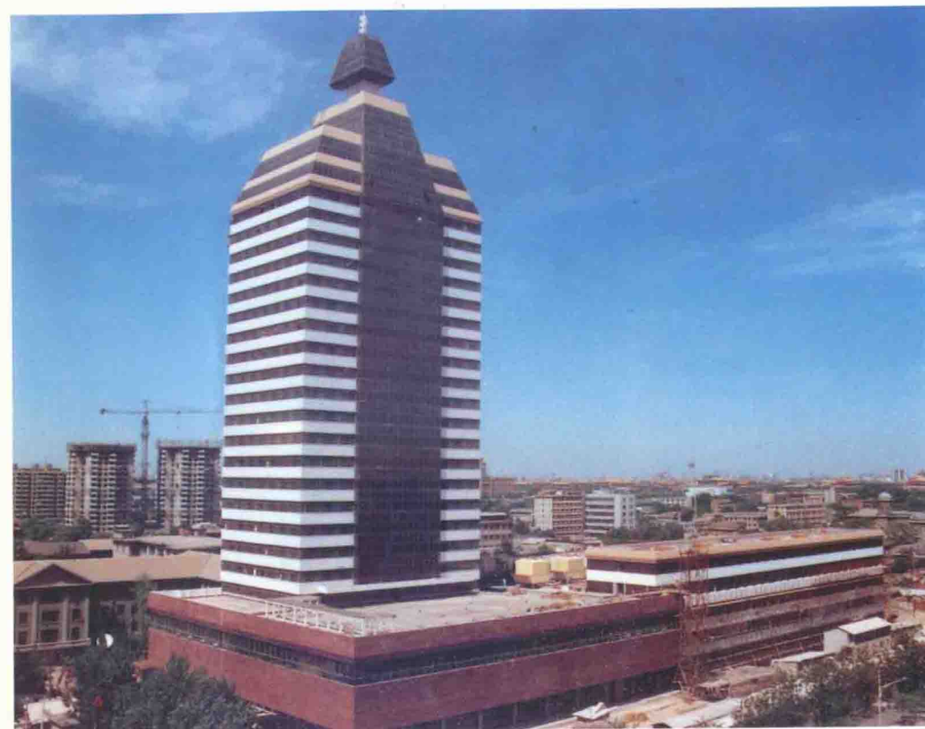
图 4—2 新华通讯社大楼外景 建设单位: 新华通讯社 设计单位: 北京市建筑设计院 施工单位: 北京市第一建筑公司 竣工日期: 1989 年 8 月
