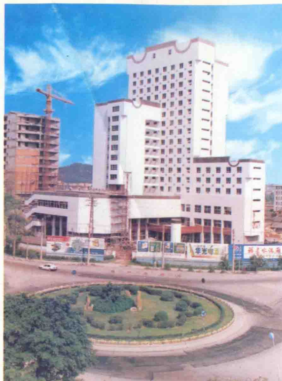
图 29—1(b)福建省物资贸易中心外景 建设单位:福建省物资厅 设计单位:福建省建筑设计院 施工单位:福建省第六建筑工程公司 竣工日期:1989 年 10 月
