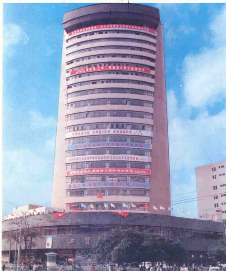
图 28—2 兰州工贸大厦外景 建设单位:兰州市工业品贸易中心 设计单位:中国市政工程西北设计院 施工单位:甘肃省第七建筑工程公司 竣工日期:1989 年 12 月
