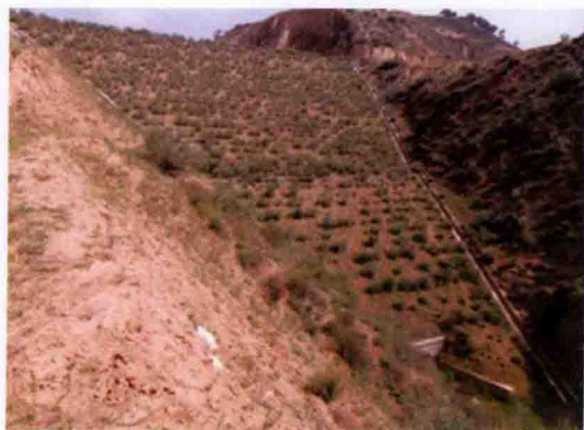
大庄窝1#骨干坝坝坡绿化
