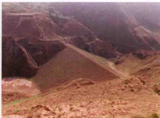
大庄窝2#骨干坝全景
