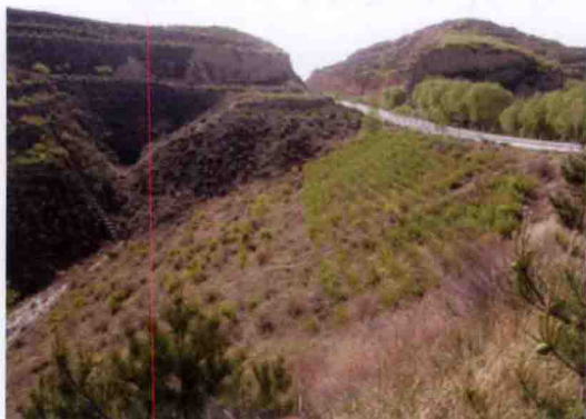
大泉沟骨干坝以坝代路
