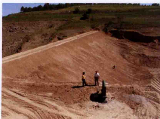
樊家窑沟1#中型坝施工现场
