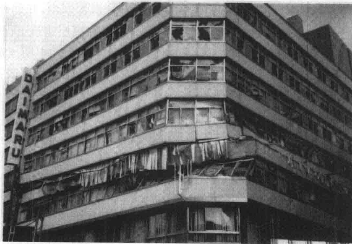
图 1.1 阪神地震建筑物扭转破坏实例
