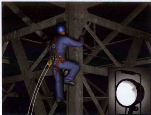
夜间抢修作业应有足够的照明设施
