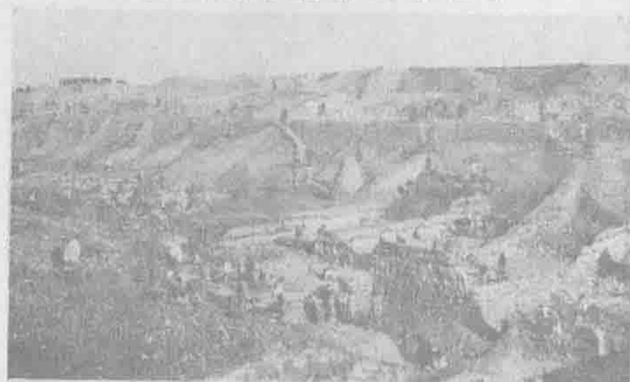
劉潤船閘閘塘挖土工程
