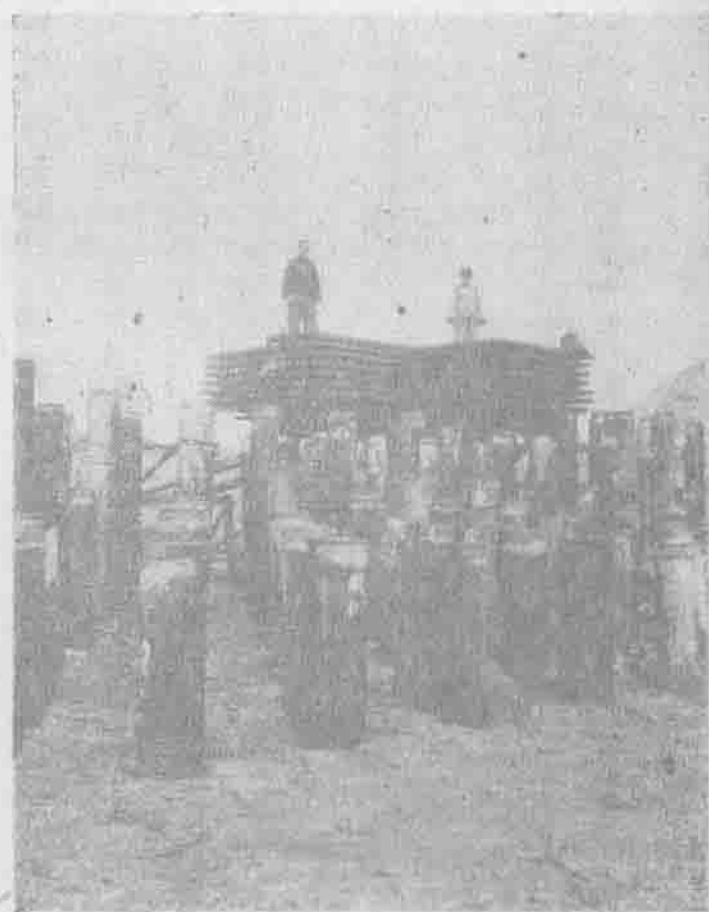
劉澗船閘基樁重載試驗
