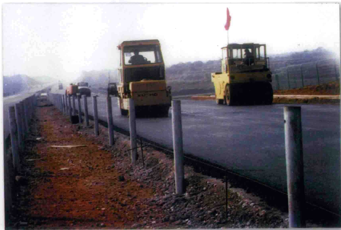
沥青混凝土路面施工现场
