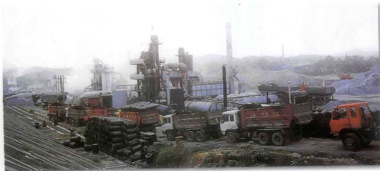
沥青混凝土拌和站
