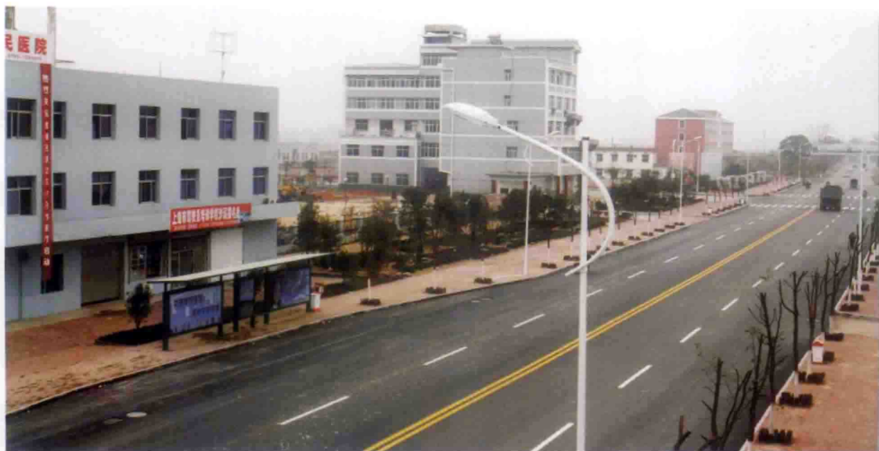
320国道，上饶境内133.011千米，自东到西贯穿玉山、广丰、信州、上饶、横峰、弋阳6个县区。
