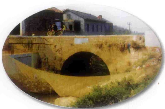
鄱阳县四十里街太平街的古桥
