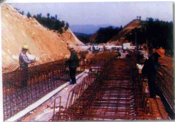
京宝工程公司在上分线（上饶——分水关）北门中桥施工现场
