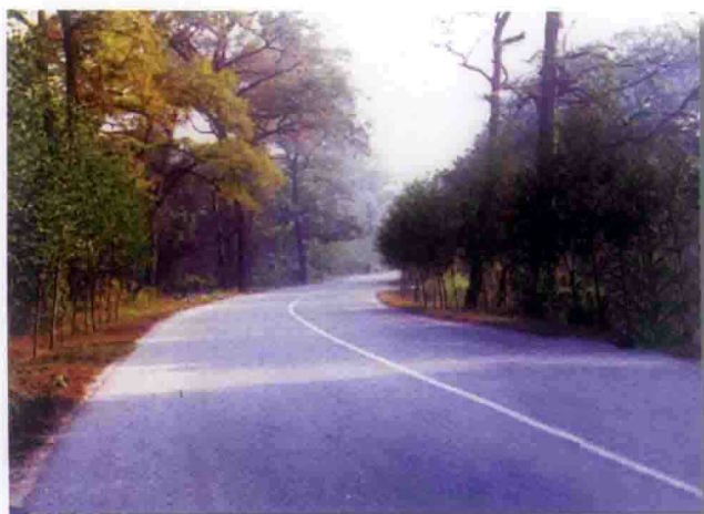
婺源县婺溪公路
