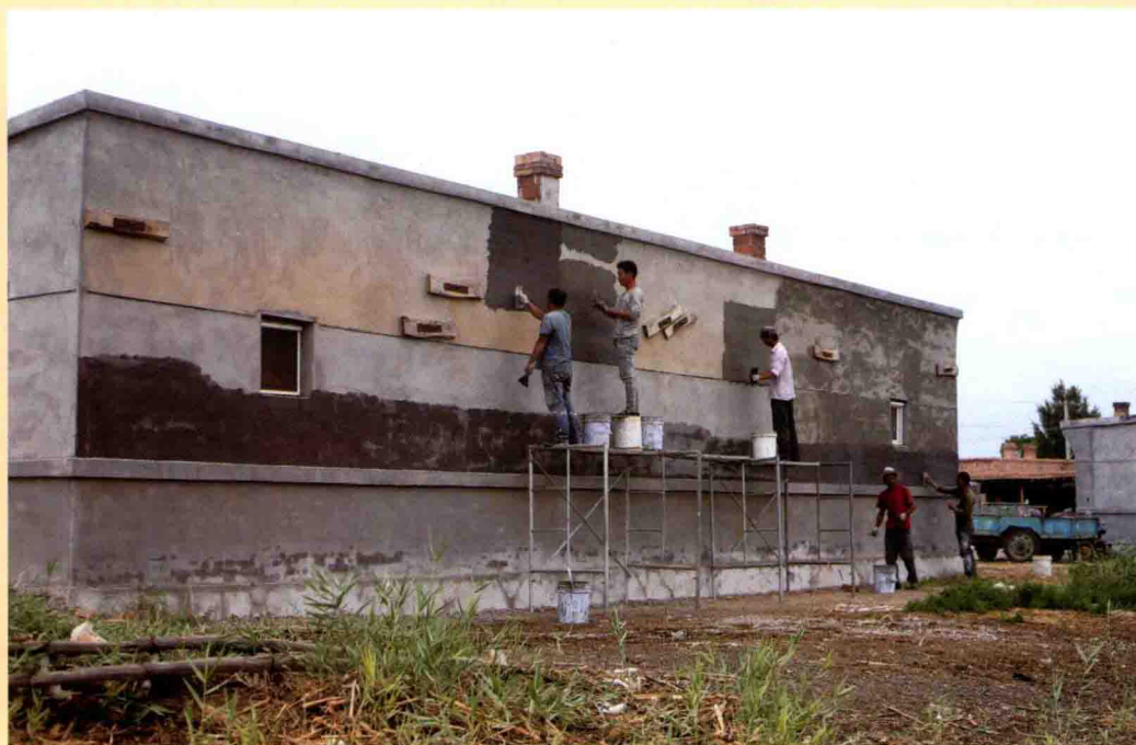
图 12 正在实施的危旧房改造项目
