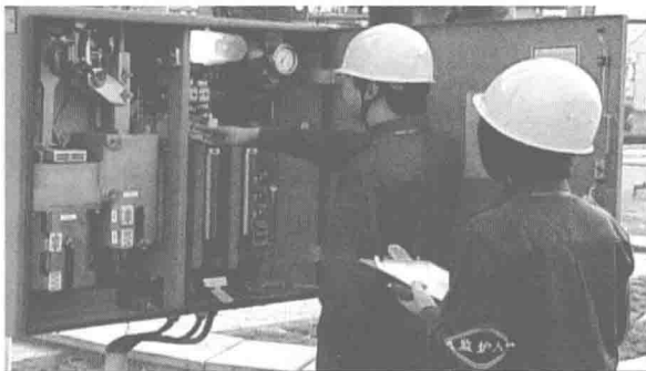
图 2-1 现场倒闸操作图
