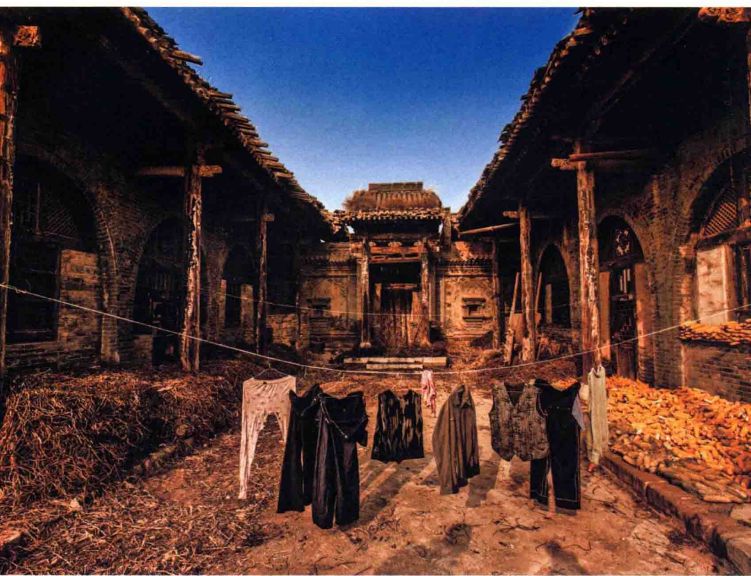
曾经的晋商大宅，气势恢宏，如今却摇摇欲坠，没有半点生机。（平遥喜村）
