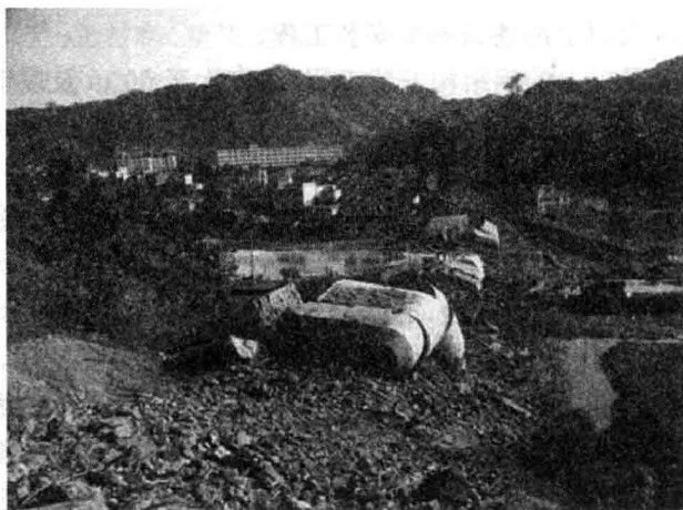
图 1-2 堤溪沱江大桥重大坍塌事故
