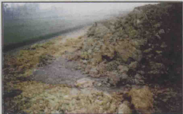
内昆铁路工程
