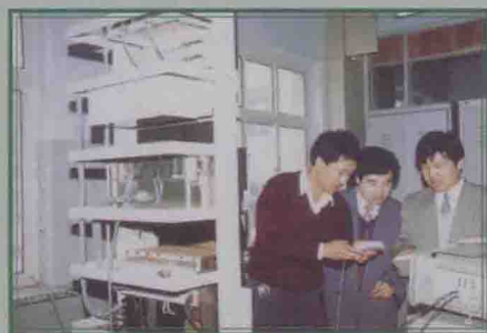
沈丹铁路通信工程光设备测试
