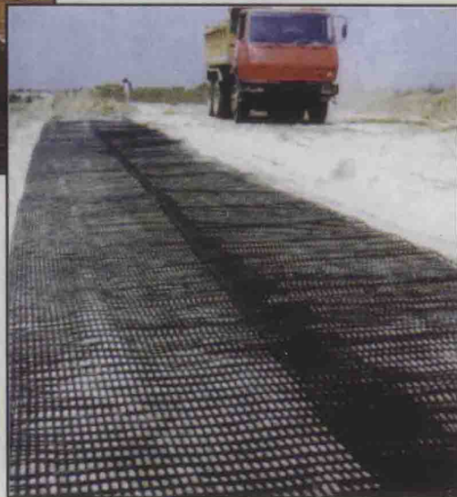
济邯铁路工程
