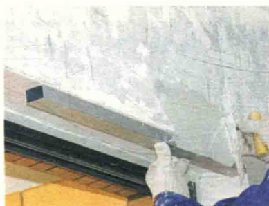
图1-9 石膏腻子刮墙
