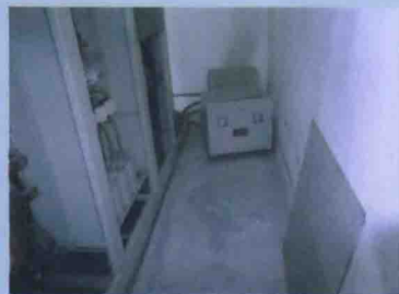
! 配电柜通道内安装调压电气设备
