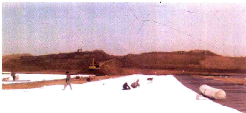
2003年9月27日，沈阳大辛生活垃圾处理场投入使用。图为工人在铺设防渗膜。
