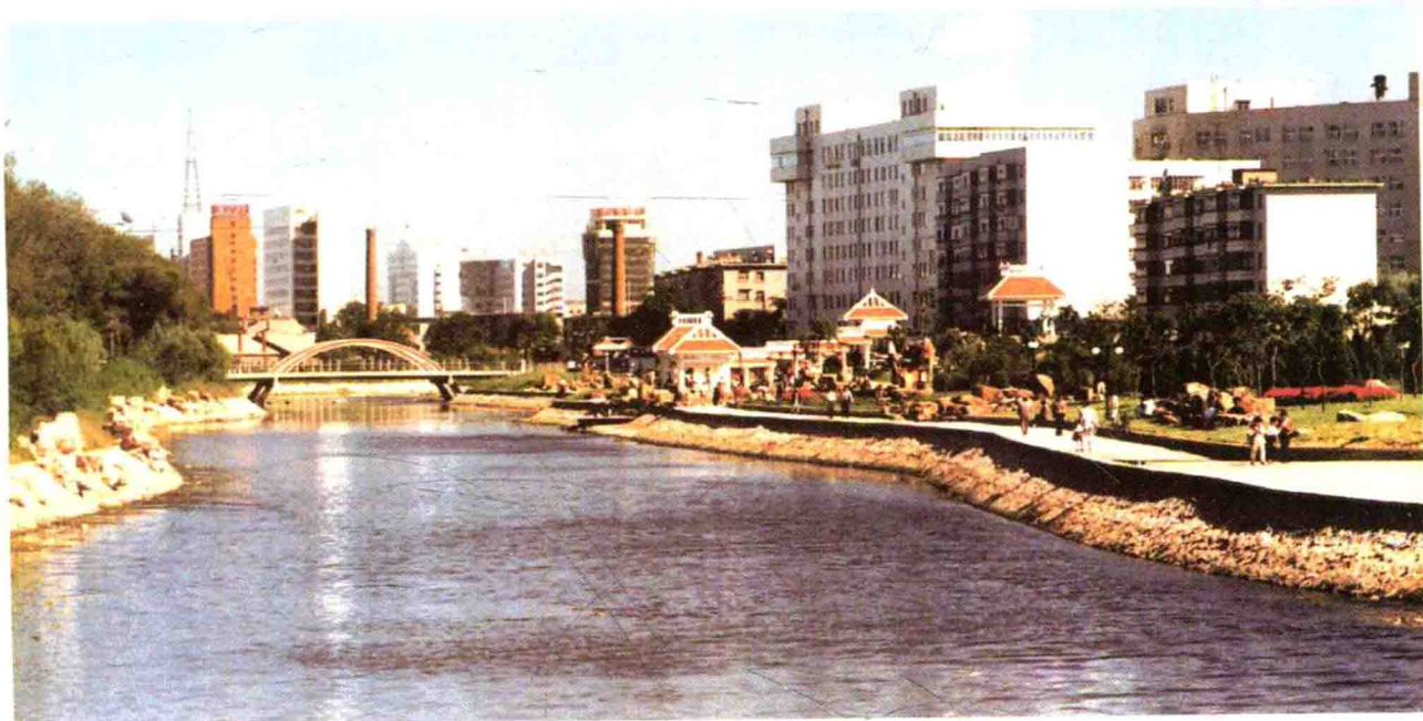
治理后的新开河（1997年）
