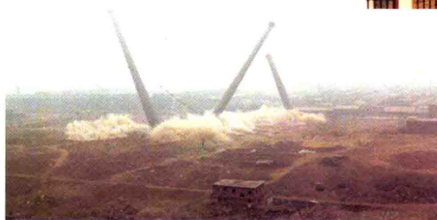
2004年3月23日清晨6时，原沈阳冶炼厂的3根百米烟囱爆破拆除。到当年8月，全市就拆除影响空气质量的各种烟囱600余根。
