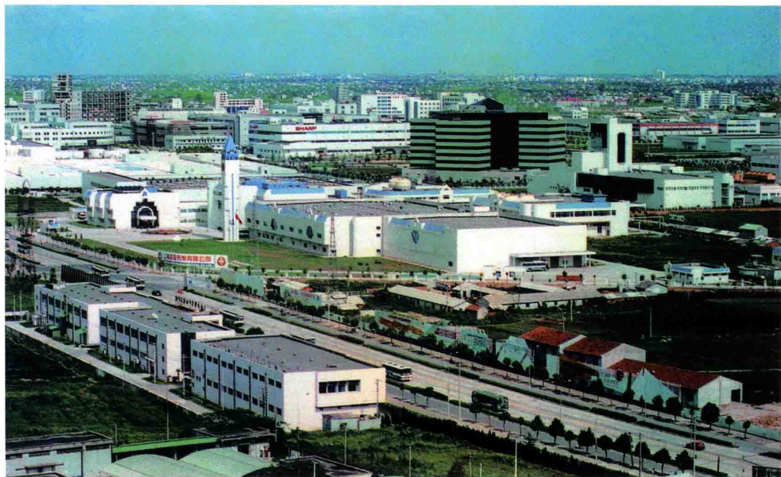
金桥出口加工区
