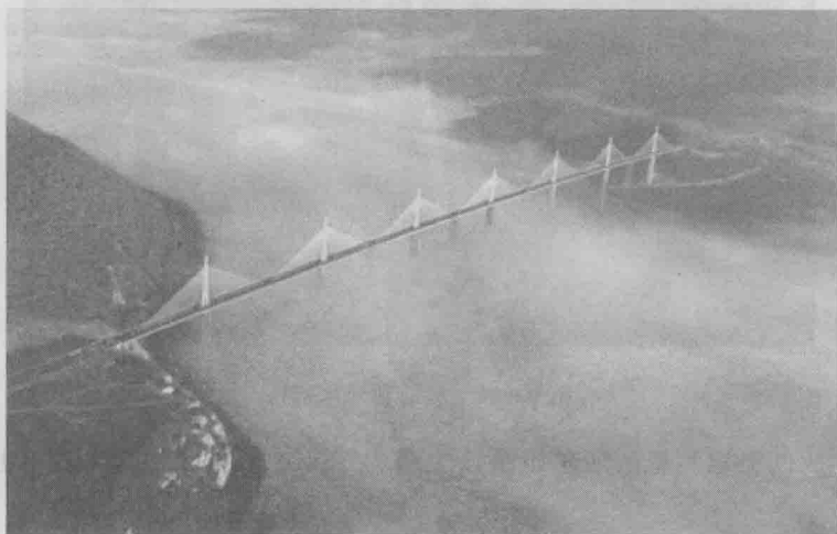
图 0-13 法国米约大桥
