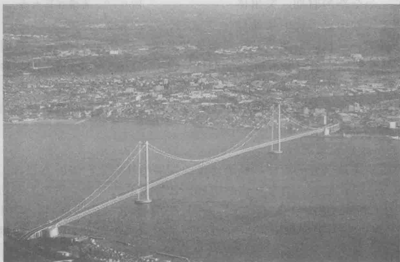
图 0-9 日本明石海峡大桥
