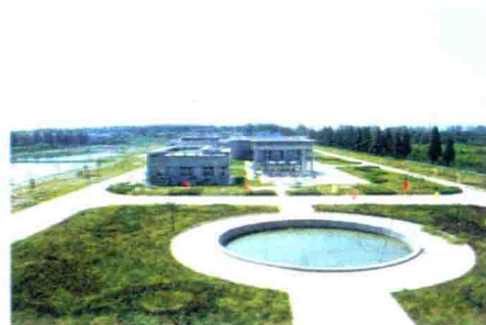
▲建成淮安市第二污水处理厂
