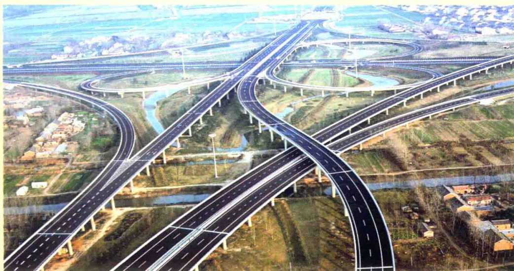
▲2006年，淮宁高速公路全线贯通，淮盐高速建成通车。图为徐淮盐高速西互通立交
