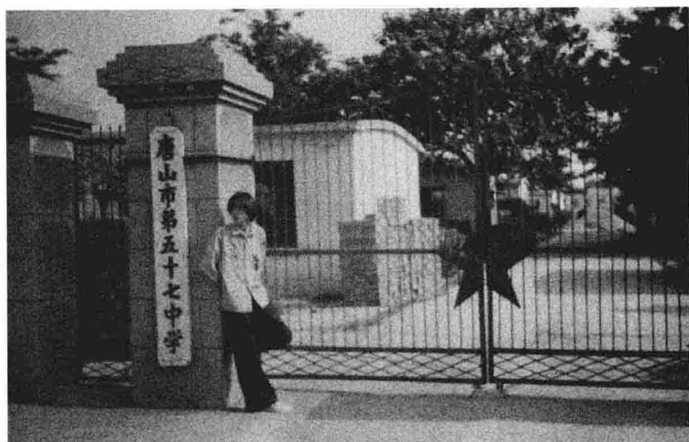
我的学生时代 第五十七中学的大部分房屋、墙壁在我上学时已有深长的裂痕了。
