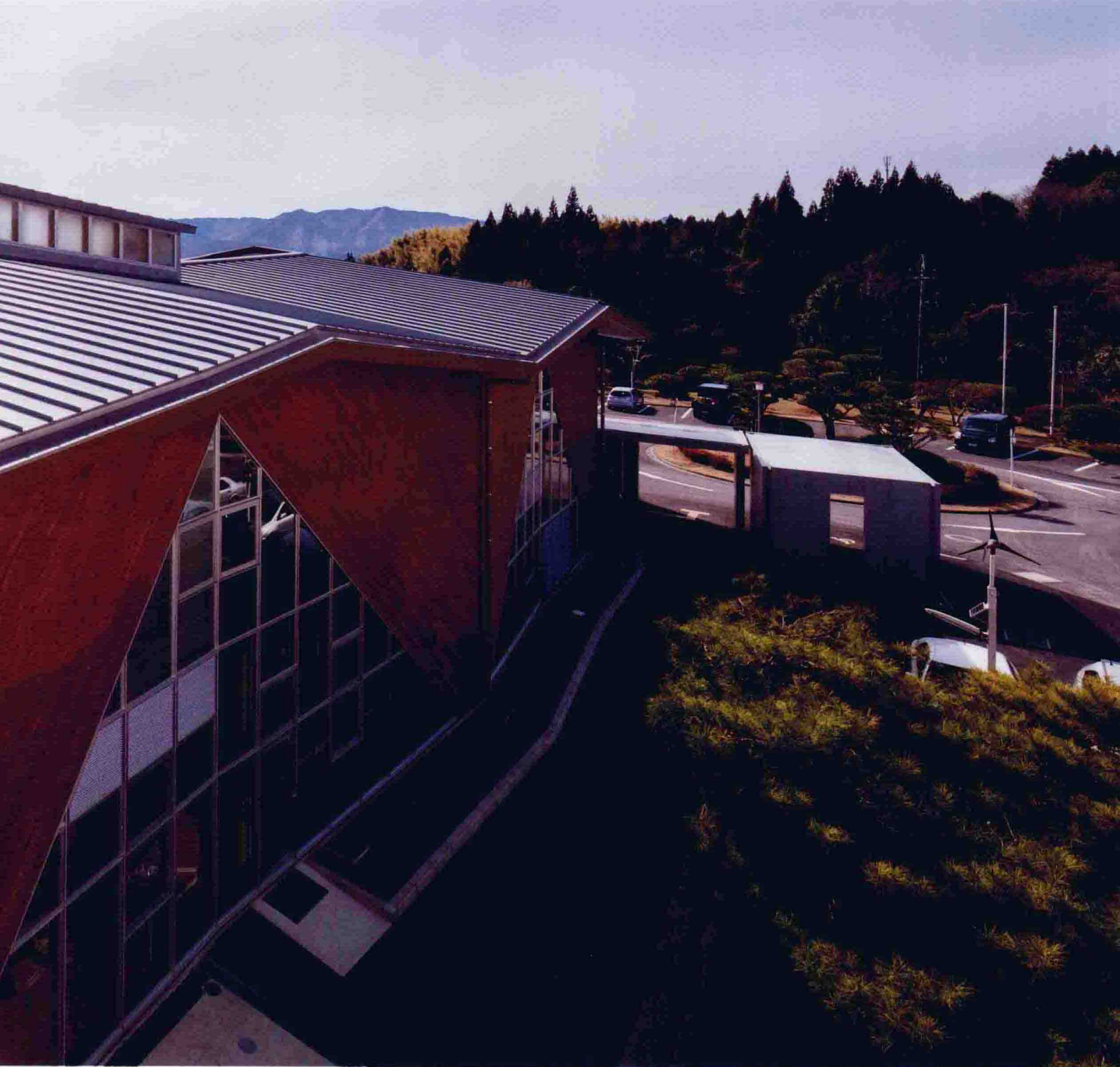
北侧视角。该项目为2层木结构建筑，位于日本《建筑基准法》第22条指定区域外，未指定防火地域。该项目高度小于13米且房檐高度不超过9米，不受防火建筑、准防火建筑的限制，因此建设过程中可以使用纯杉木材
