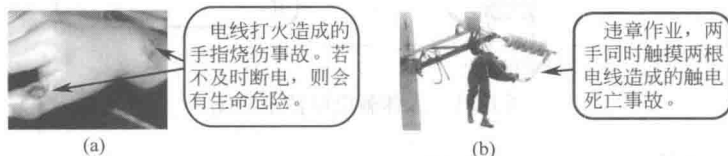
图 1-10 触电烧伤及触电死亡事故
