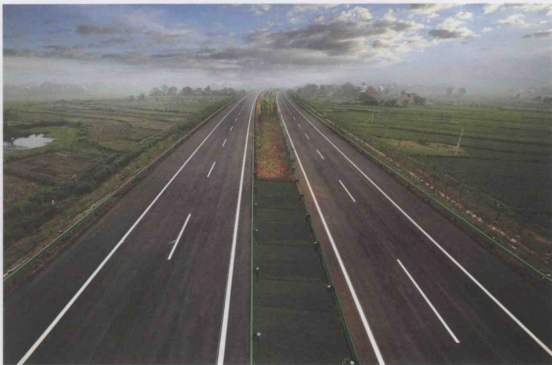
沿江高速公路建成通车
