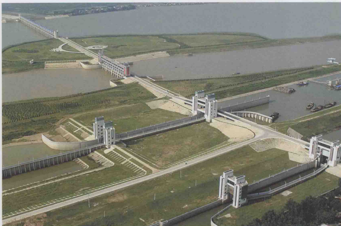
淮河临淮岗洪水控制工程建成（胡波 陈力 摄）
