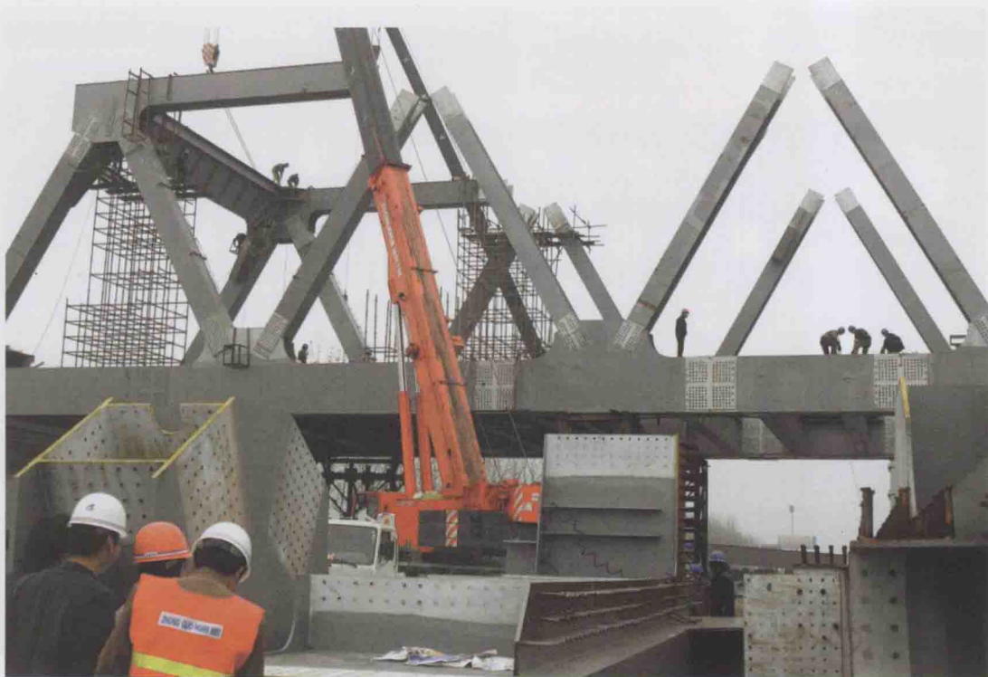
在建中的合（肥）宁（南京）高速铁路跨越合芜高速公路铁桥（陈志勇摄）
