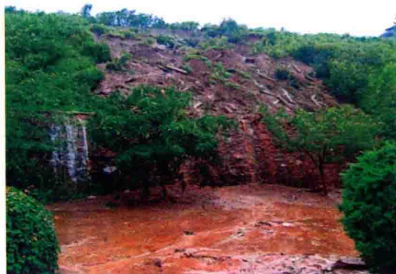
8月13日，铁岭市暴雨洪涝冲毁公路
