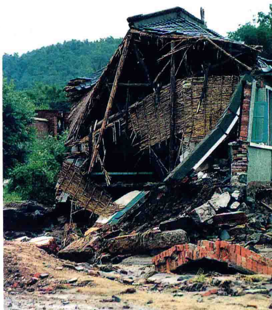
本溪满族自治县山城子镇陈英村民房被洪水冲毁
