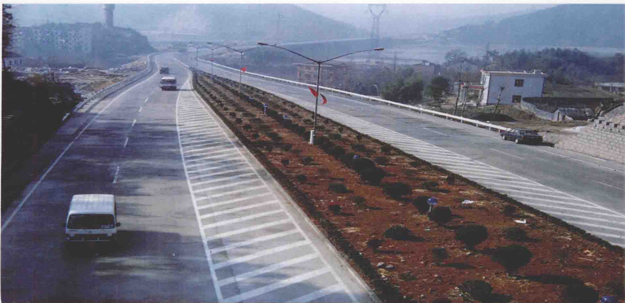
省道——杭昱线临安段一级公路
