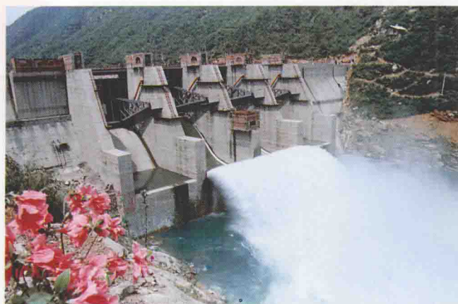
青山殿水电站
