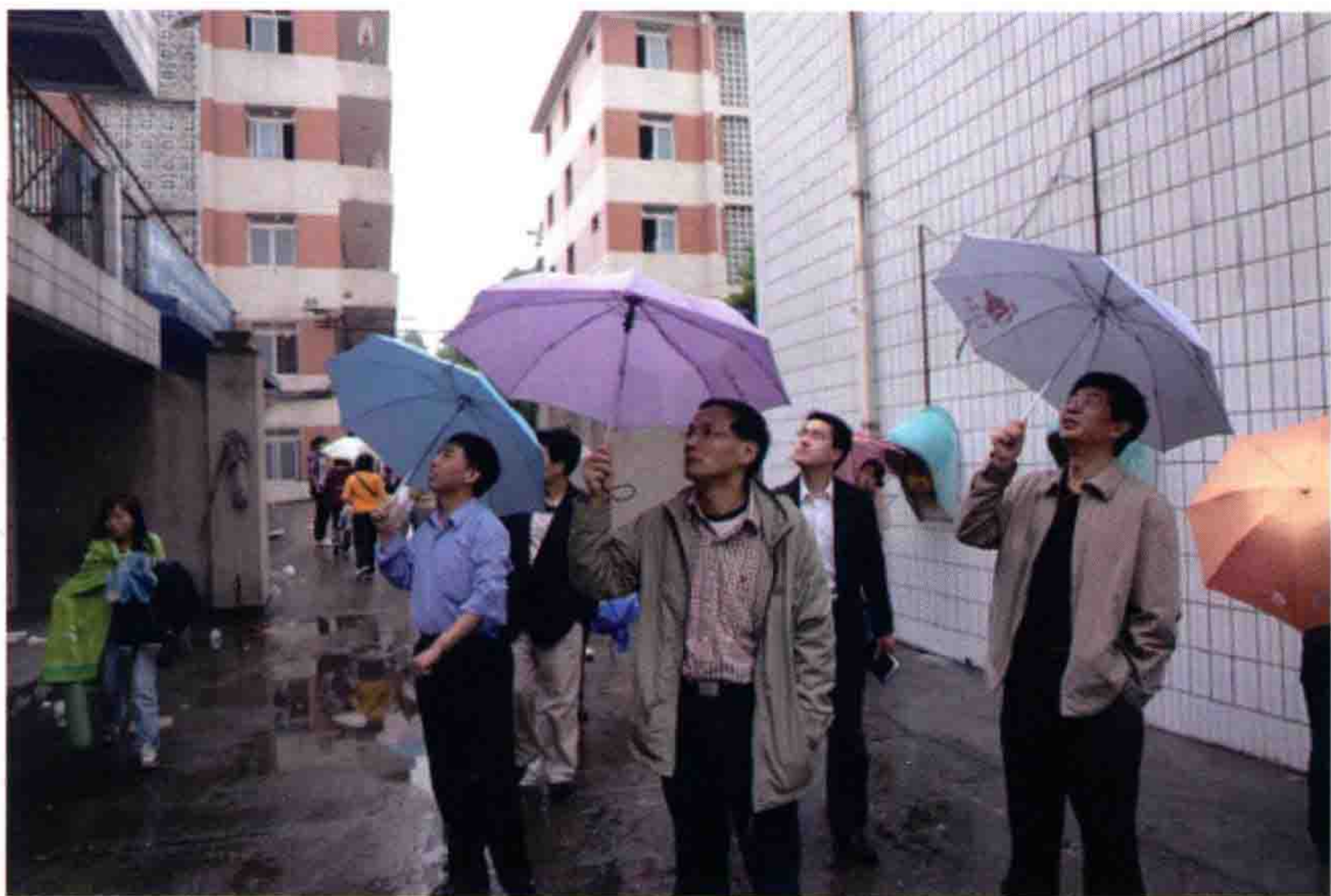
5月12日下午起，学校应急领导小组对全校建筑物进行全面检测
