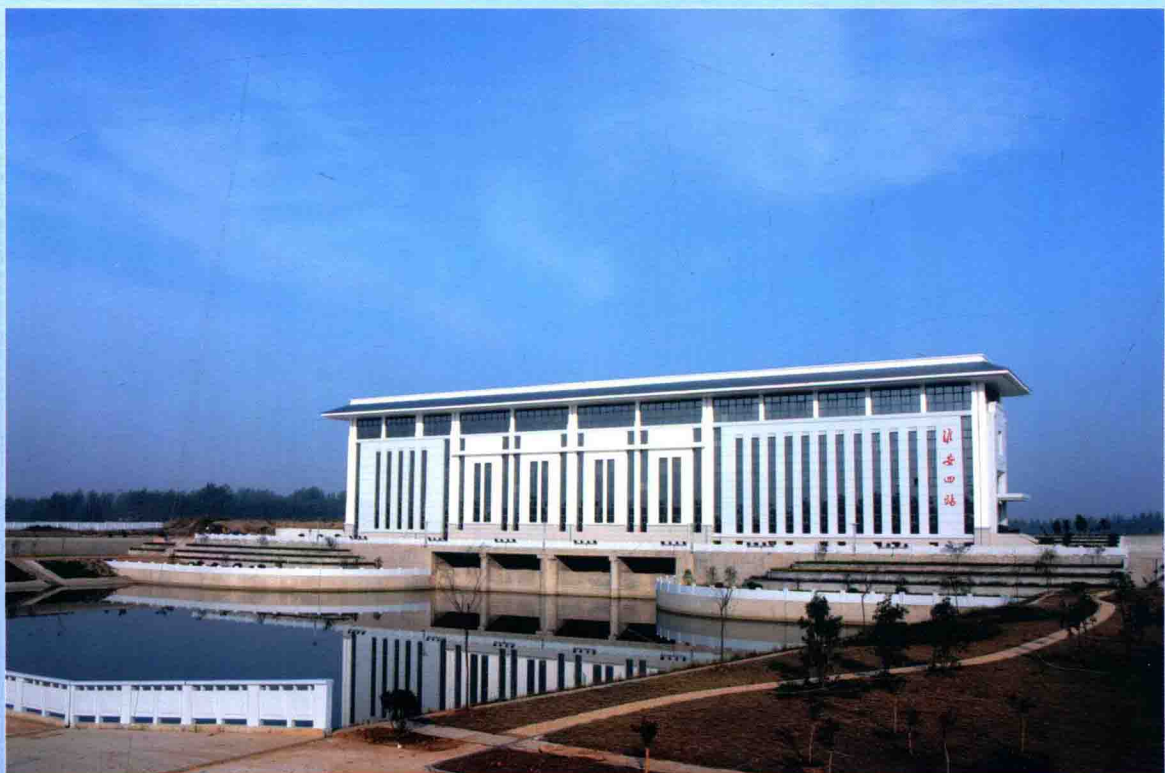
南水北调淮安四站
