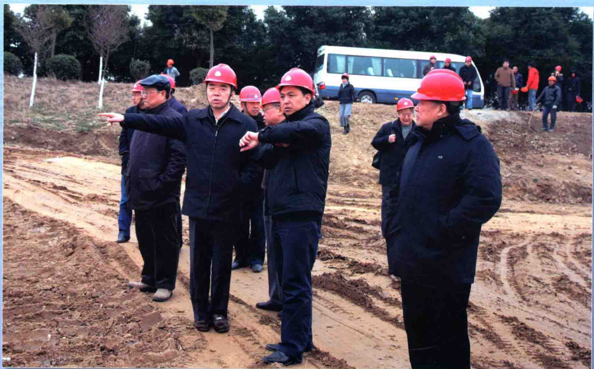
常熟水利枢纽加固工程于2008年12月8日开工,吕振霖厅长多次现场办公,要求以最好的质量、最快的工期、最安全的施工完成消险加固改造工程
