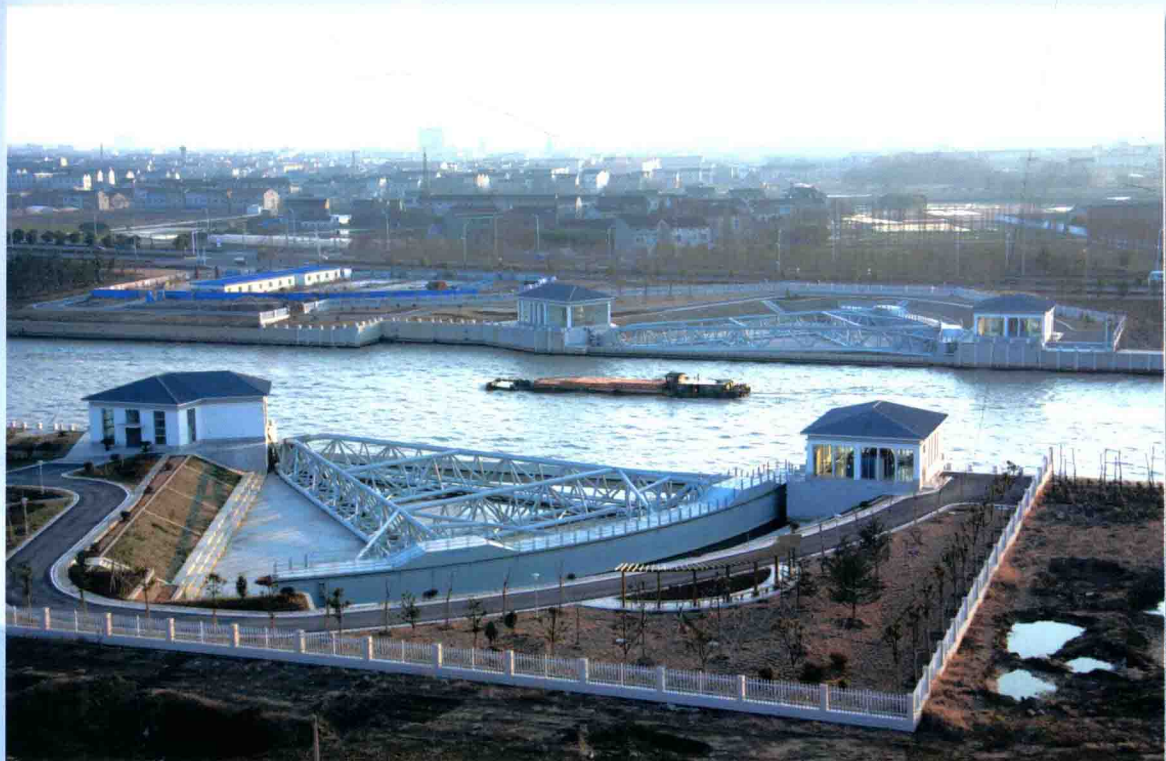
常州钟楼防洪控制工程
