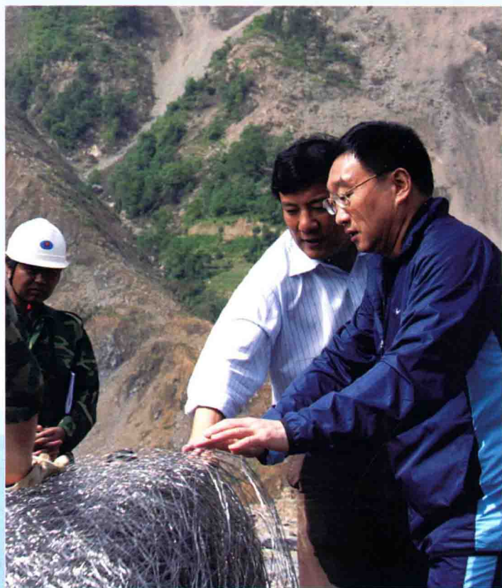
2008年5月26日,从江苏省水利厅紧急调运的钢丝网笼空运到唐家山抢险现场,陈雷部长、矫勇副部长在指挥抢卸
