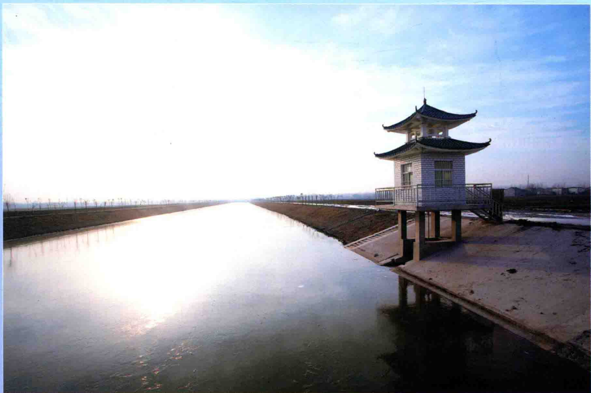
通榆河北延送水工程新开河道
