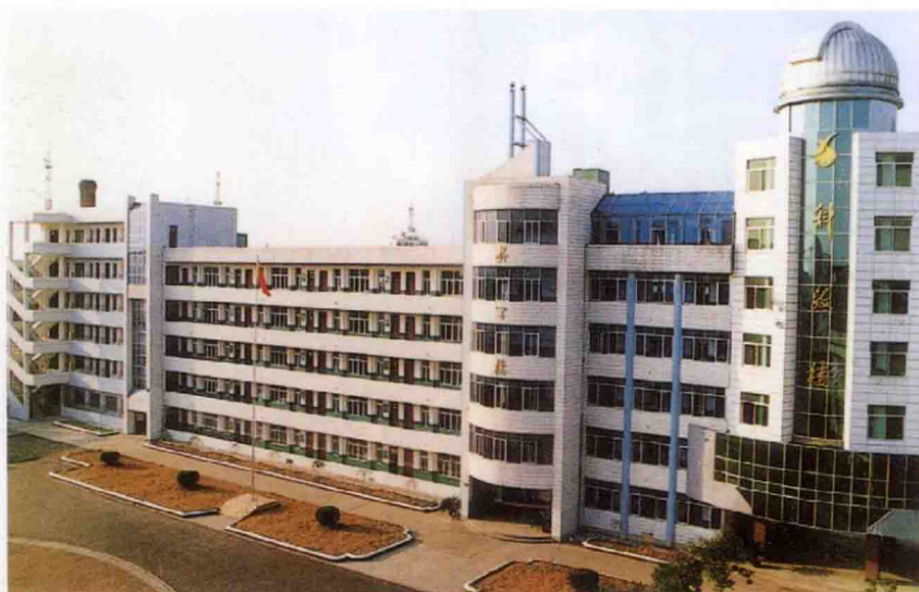
市第一高级中学教学楼、科技楼
