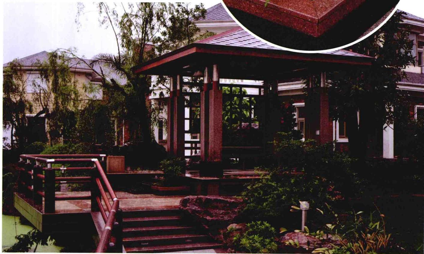
景亭的立柱采用混凝土浇筑外贴大理石面砖，预制脊瓦作为屋顶，加上色彩的过渡及木质长椅的搭配，景亭整体显得轻巧没有沉重感。
