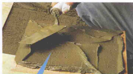
无论是铺贴墙砖还是地砖，都应在砖体背后均匀涂抹素水泥，提高黏结性能。
