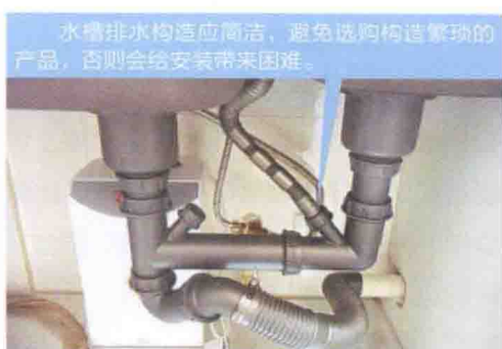
图1-13 水槽排水安装
