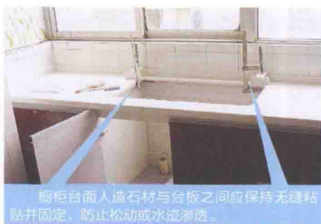
图1-12 橱柜台面安装
