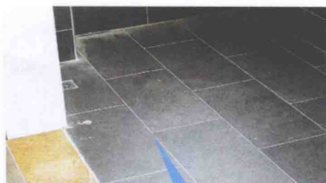
地面铺装后应在第一时间填补缝隙，保持地面整洁。
