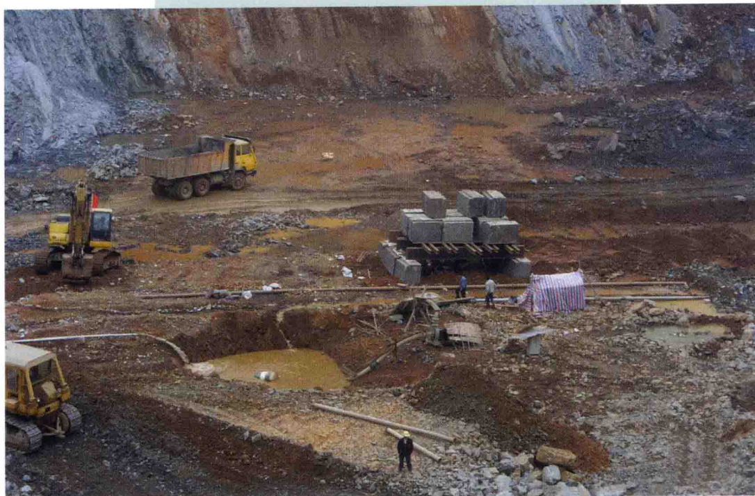
消力池施工开挖及全强风化岩体现场载荷试验
