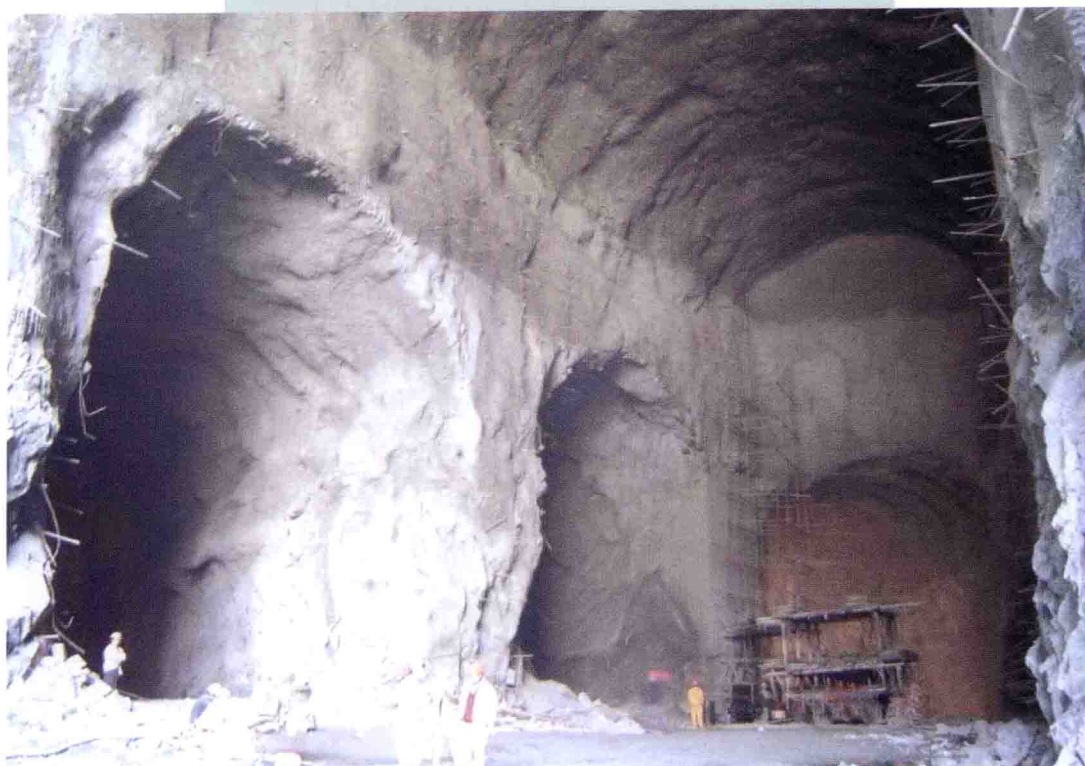
施工过程中的“四合一”尾水主洞
