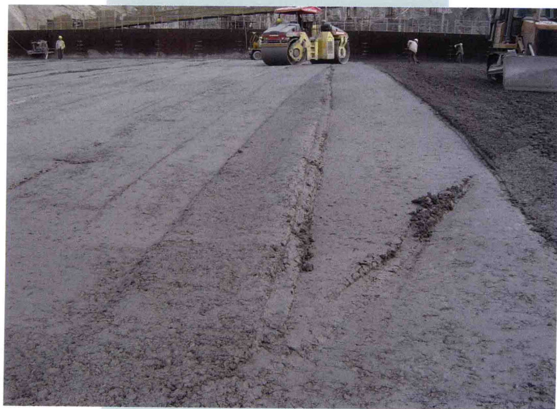
主坝碾压混凝土施工
