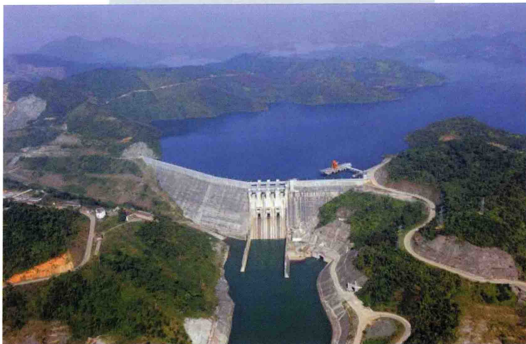
百色水利枢纽主坝区全景（梁毅于2010年12月摄）
