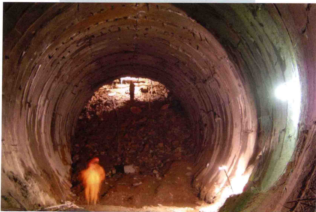
引水隧洞下平洞沉积岩段施工开挖
