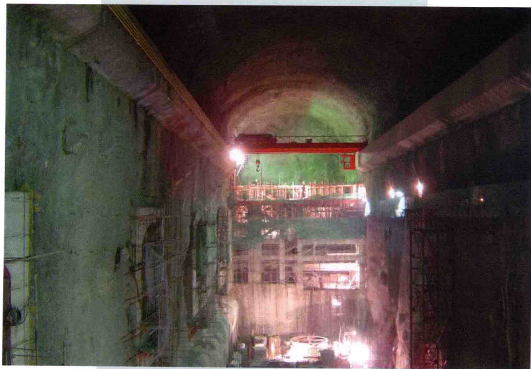
施工过程中的厂房洞
