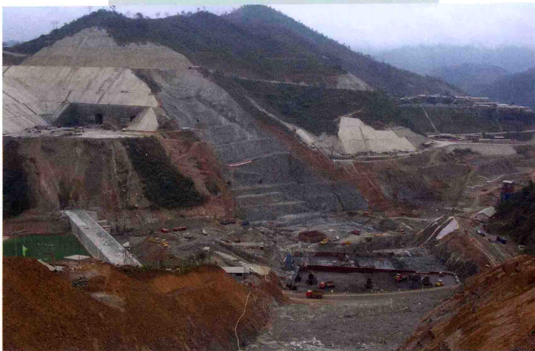
主坝河床及左岸
