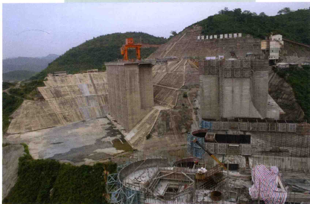
水电站进口及大坝混凝土施工
