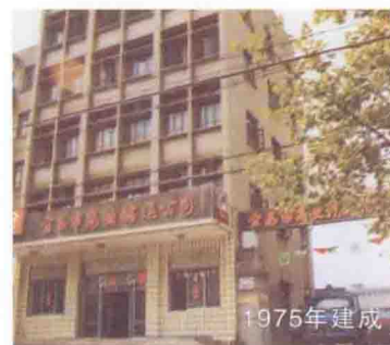
宜昌市商业储运公司 地址:东山大道
