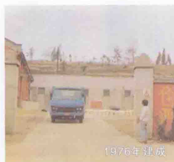
宜昌市商业储运公司花艳仓库
