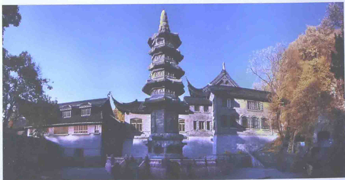
图8 栖霞寺舍利塔 修缮建筑师：刘敦桢、卢树森
