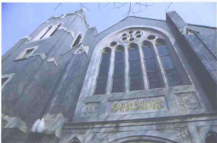
图1 南京莫愁路基督教教堂入口 建筑师：陈裕华
