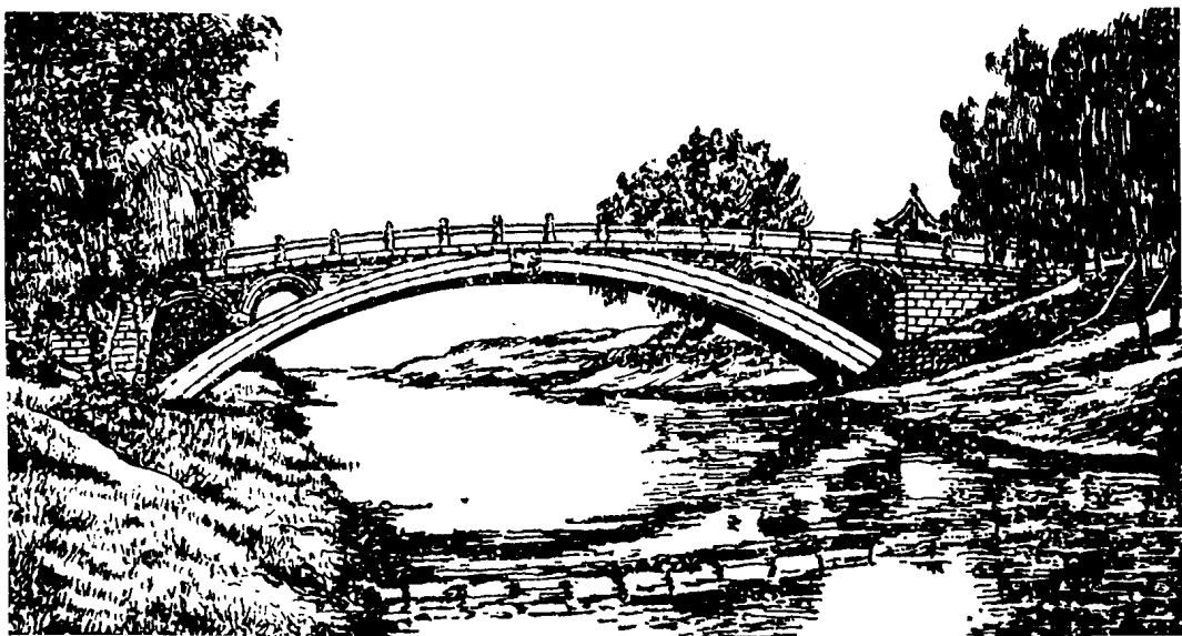
图 1-1-10 河北赵县赵州桥(公元 605 年)
