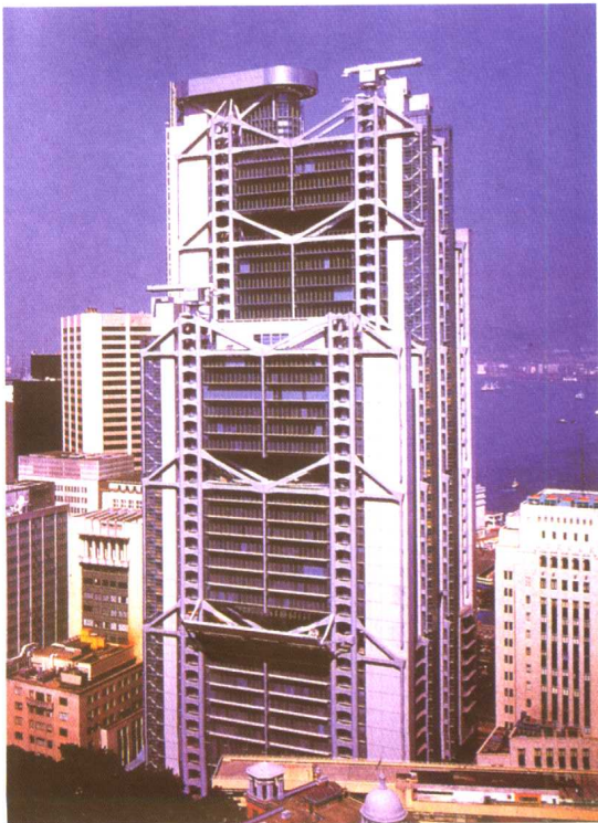
香港汇丰银行大厦
