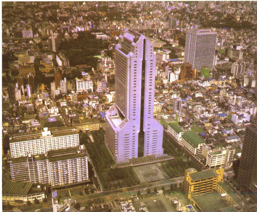
东京 NEC 大楼鸟瞰
