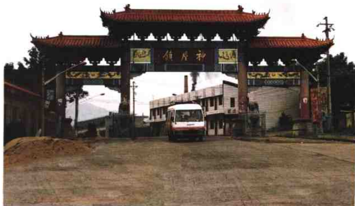
神垕镇牌楼 神垕镇人民政府 1995 年重修
