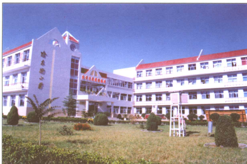
新建的渝东 街小学教学楼
