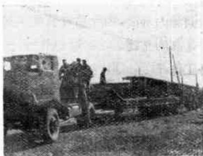
圖 10 構件已從平板拖車拖移至斜坡跳板逐步卸下
