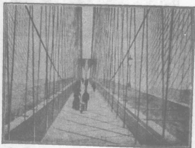
第十二圖 這圖表示布魯克林橋 Brooklyn Bridge 的步行道。這橋接連布魯克林和曼里達 Manhattan 兩個地方，是大橋中頂早的橋。像這樣的橋，現在有四個了。都有分道預備行人，街車，火車，等通行。
