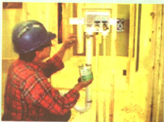
图1.1-10 安装水、煤气管道
