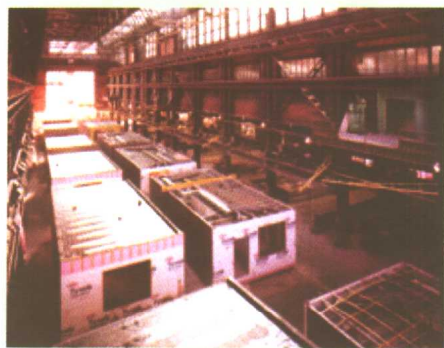
图1.1-6 住宅装配生产线
