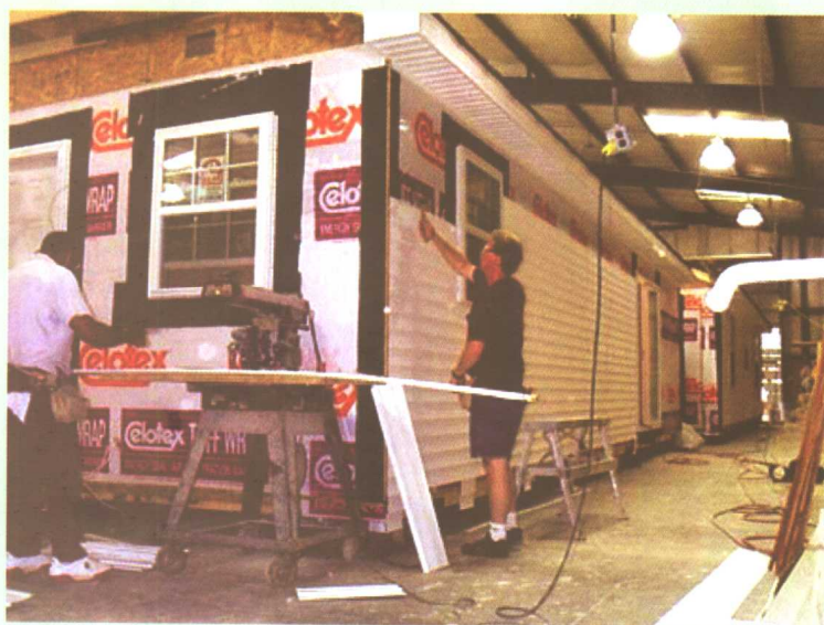
图1.1-7 装配外墙挂板
