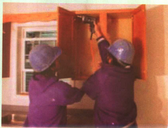
图1.1-11 安装吊柜
