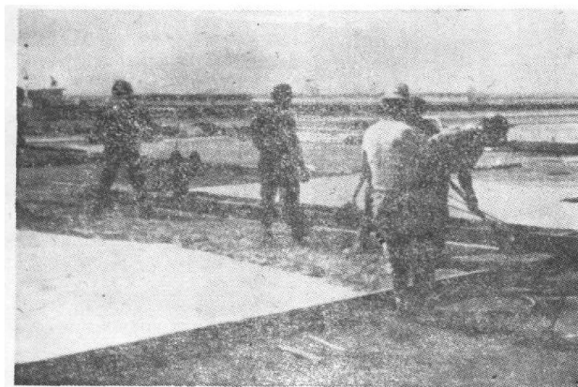
图 2 1974 年在纽约肯尼迪国际机场的一条跑道上铺筑一个非粘 结式钢纤维混凝土罩面 ( 127 毫米 [ 5 英寸 ] 厚 ) 的施工情况
