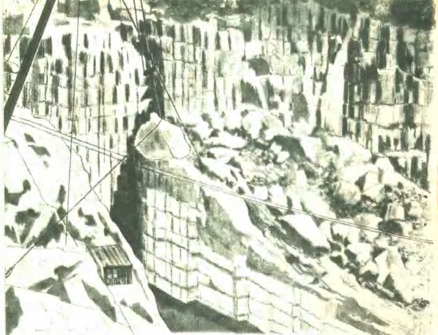
工人用巨大的起重機將大岩石吊升起來。在礦區裏，工人正在操作起重機將大石塊搬移至別處。
