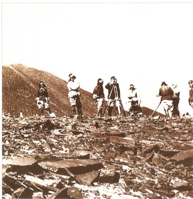
◀ 查勘队员在引水线路上测量地形 (1952年摄)
