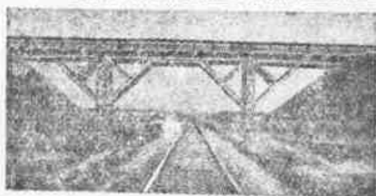
圖10 橋底在鐵路上的高架橋
