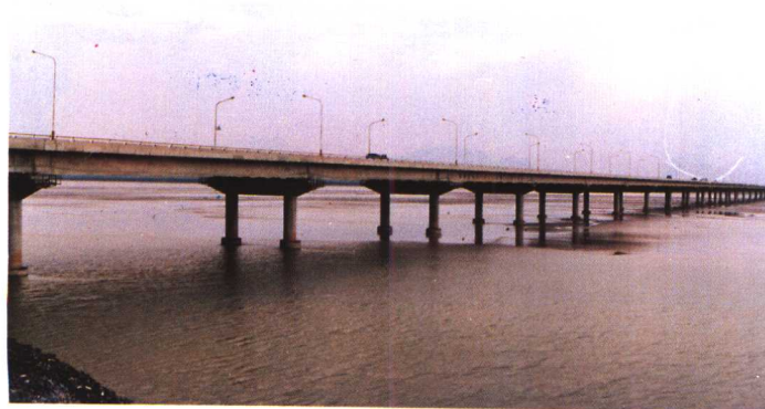
开封黄河公路大桥
