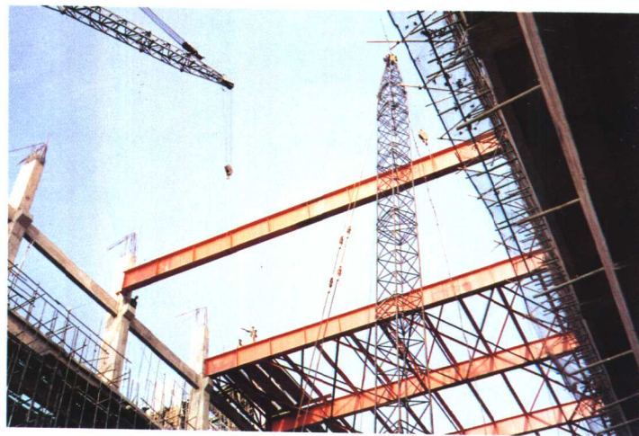
安装中的三门峡火电厂
