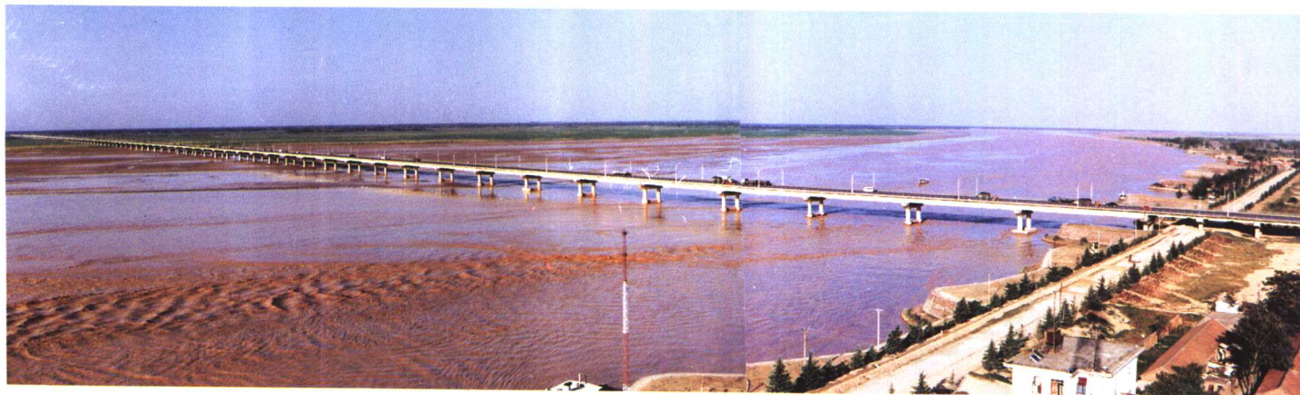
郑州黄河公路大桥
