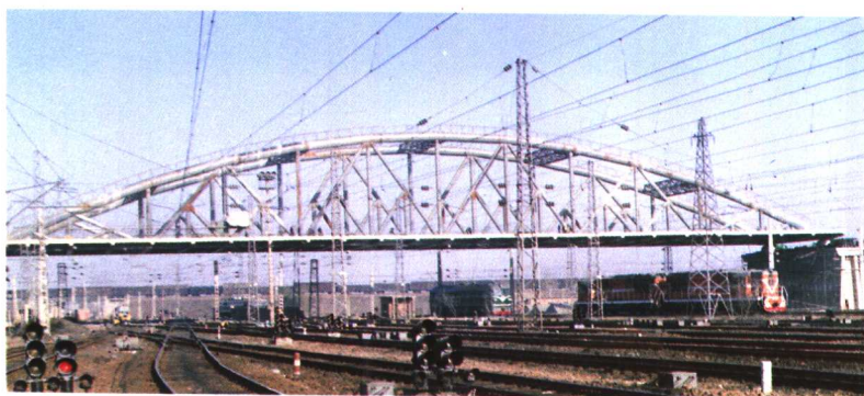
跨越亚洲最大编组场的 122 米钢管混凝土曲弦公路桥
