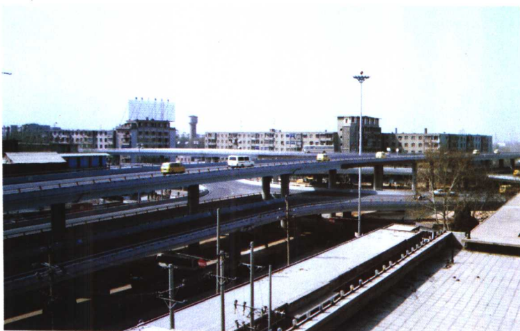
河南医学院立交桥
