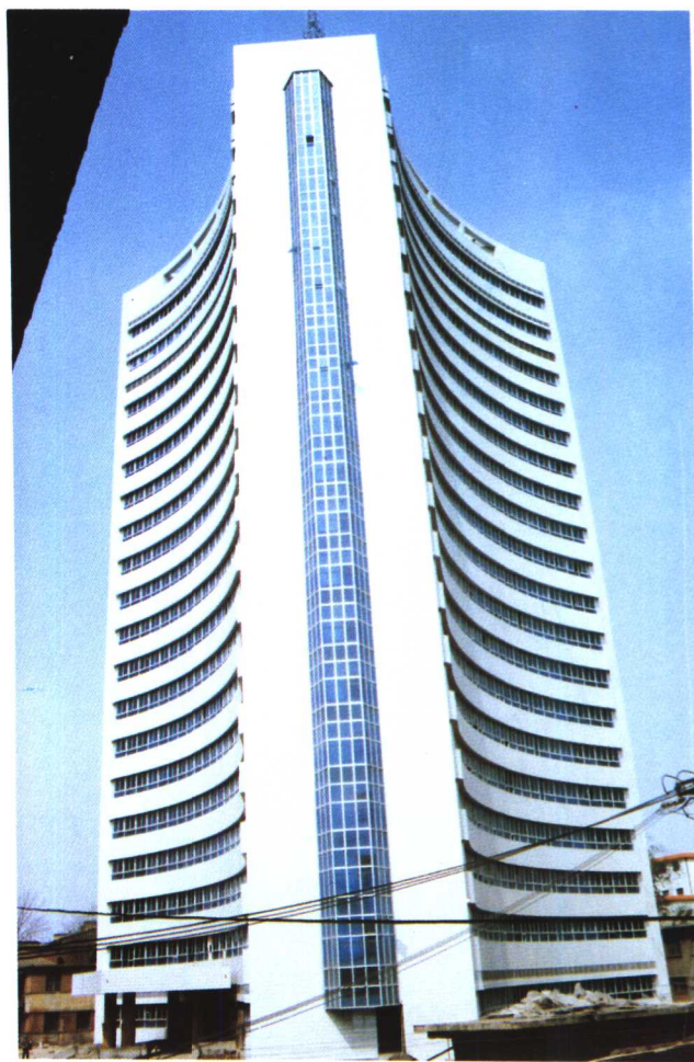
郑铁中心医院综合病房楼
