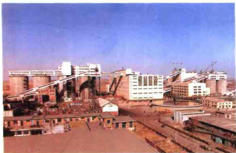
图 5-7-2 1988 年 11 月建成投产的钱家营洗煤厂外景
