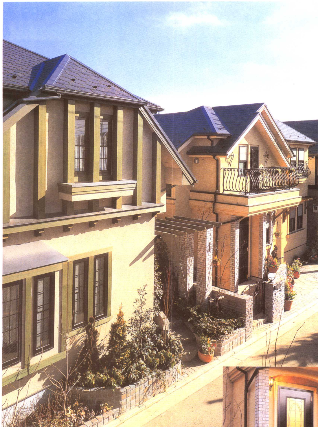
建筑名称: 武藏境シーズンズコート住宅区 坐落地点: 東京都武藏野市境3丁目 建筑面积: 92.50\text{m}^2 \sim 120.79\text{m}^2 (户) 居住户数: 58户
