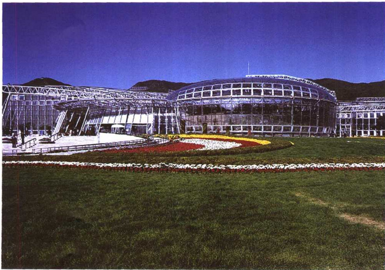
大温室外景全貌
