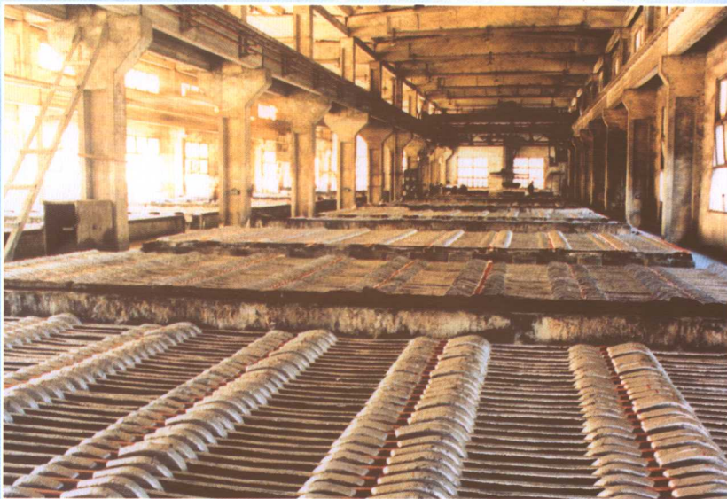
▲云南新立有色金属有限公司电解铅生产车间
