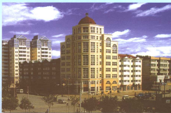
莱钢H型钢钢结构节能住宅、山东省钢结构节能住宅示范工程樱花园住宅小区
