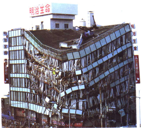
在日本，一次地震中被破坏了的建筑物
